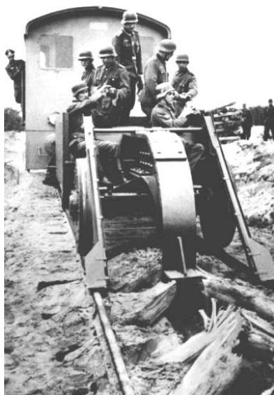
Уничтожение немцами ж.д. путей при отступлении, 1943 г.
