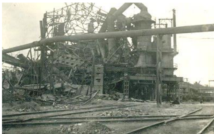
Разрушенная домна завода имени Ильича
